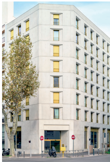
L'hôtel 2 étoiles de 111 chambres réalisé en 2025 à Marseille dans le quartier Euroméditerranée.
