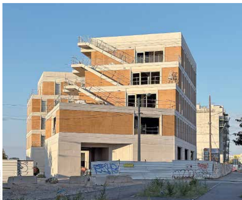
De nombreux matériaux bio et géosourcés ont été utilisés : bois, paille de riz, terre crue, chaux et chanvre.
